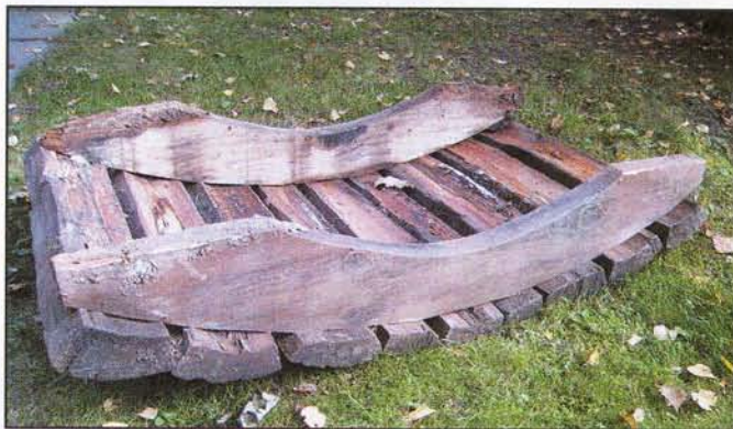
Основу конструкции составляют две дугообразные опоры, выкроенные из сосновой доски.
