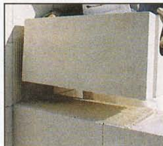
Укладываемый сверху блок следующего ряда фиксирует анкерную пластину.
