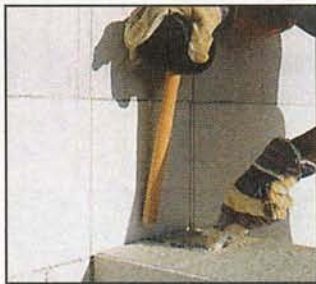
Пластины отгибают от стены и прижимают к уложенному блоку, вдавливая в нанесённый на него раствор.
