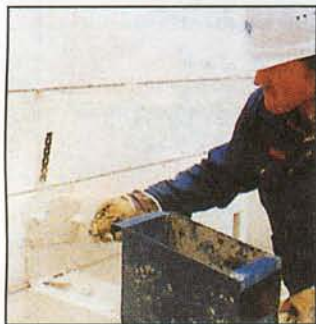
При соединении перегородки со стеной встык соединительный шов шириной 2 см заполняют раствором.
