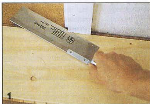
Подпиливать стойки дверной коробки удобно ручной пилой с мелким зубом по перевёрнутой паркетной доске в качестве мерной прокладки.
