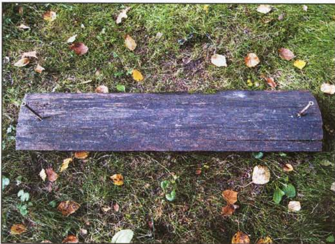
Из таких дубовых деталей и собран мостик. По краям каждая из них зафиксирована саморезом длиной 100 мм.
