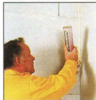
Соединительные швы между перегородкой, возведённой из крупноформатных элементов, можно заполнить монтажной пеной.
